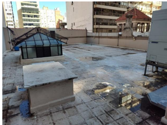
CUBIERTA NO ACCESIBLE
