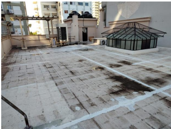
CUBIERTA NO ACCESIBLE
